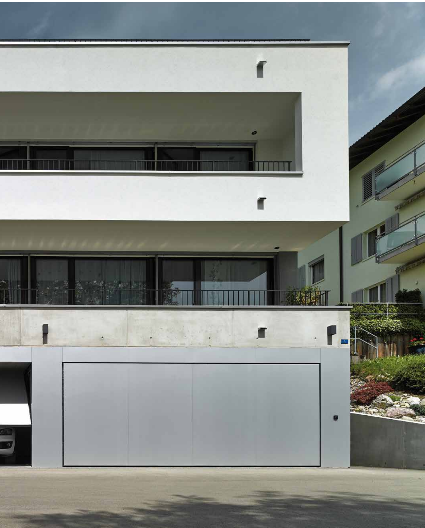
▲ Kiptor ET500, Motiv 405 mit bauseitiger Beplankung, flächenbündig eingebaut
